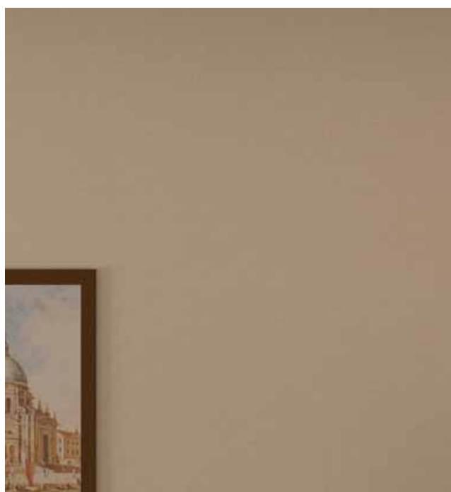
Aspetto altoparlante installato View of the installed speaker
